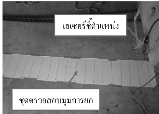
รูปที่ 7. การติดตั้งชุดตรวจสอบระยะและมุมด้วยเลเซอร์
