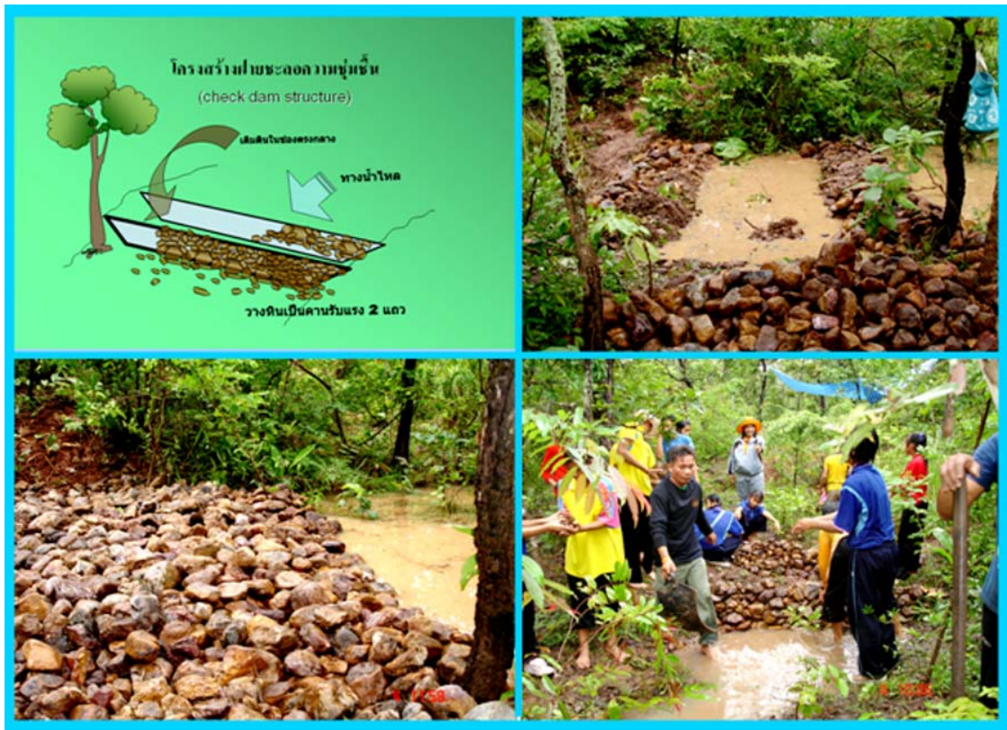
รูปที่ 3. โครงสร้าง และ การก่อสร้างฝายชะลอความชุ่มชื้นในร่องน้ำใส ป่าโคกพองใหญ่
