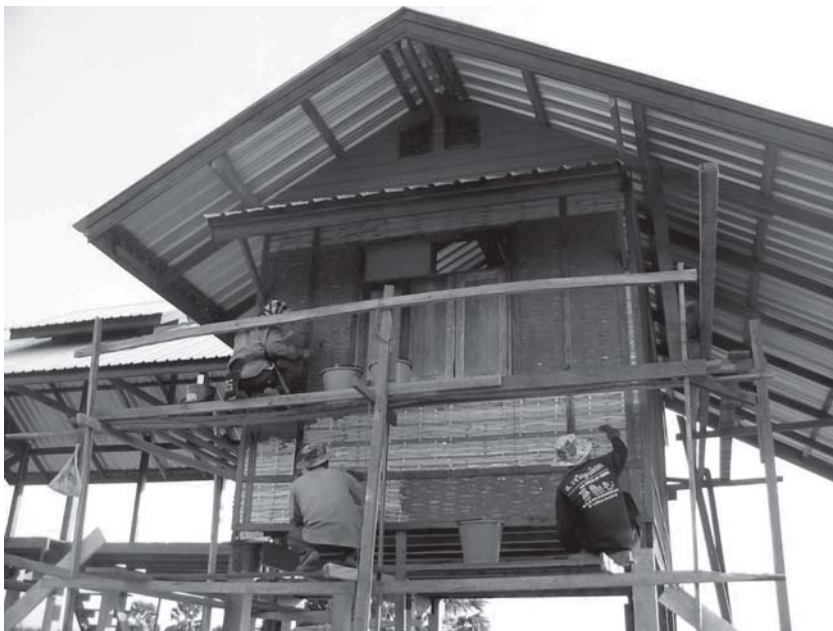
รูปที่ 8 แสดงการฉาบผนังไม้ไผ่ด้วยส่วนผสมดิน
