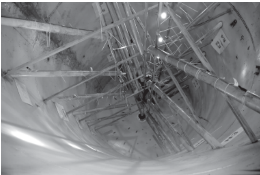
รูปที่ 3 อุปกรณ์วัดอุณหภูมิของข้าวเปลือกที่ติดตั้งในไซโลเหล็ก
