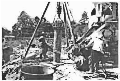
ภาพที่ 4 แสดงงานเสาเข็มชนิดเสาเข็มเจาะ
