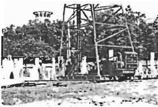
ภาพที่ 3 แสดงการตอกเสาเข็ม
