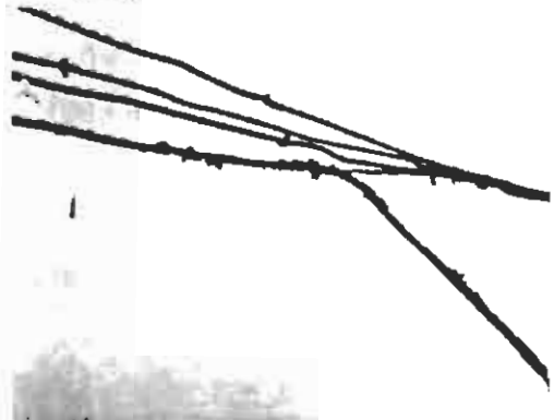
ภาพที่ 12 แสดงสายเมนไฟฟ้าสำหรับงานก่อสร้างที่อันตราย
