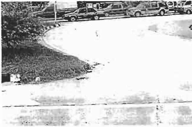
รูปที่ 17 ขอบของเกาะแบ่งช่องทางจราจรชำรุดเสียหาย
