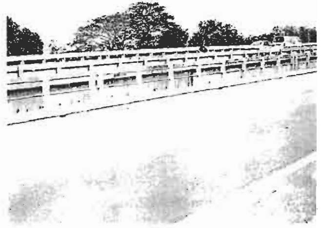
รูปที่ 20 ผิวจราจรมีระดับความสูงเกือบเท่าผิวทางเดินเท้า
