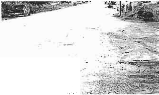
รูปที่ 10 ผิวถนนและไหล่ทางของถนนไปตำบลเมืองเก่าชำรุด
