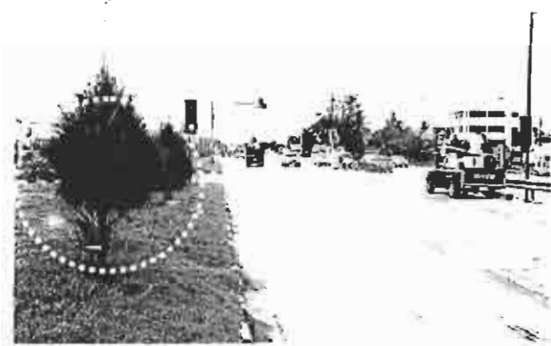
รูปที่ 5 พุ่มไม้บนเกาะกลางถนนบดบังการมองเห็นของผู้ขับขี่
