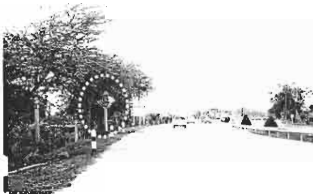
รูปที่ 12 ป้ายจราจรถูกบดบังโดยต้นไม้ข้างทาง
