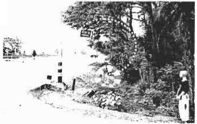
รูปที่ 6 ดันไม้และพุ่มไม้บริเวณปากทางเชื่อมถนนมีรูปภาพที่บดบังการมองเห็นของผู้ขับขี่
