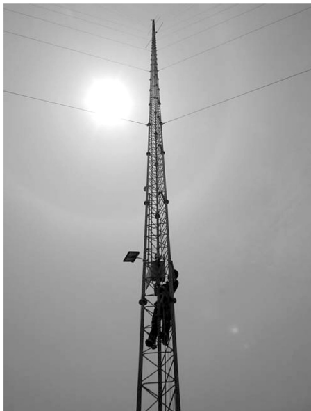
รูปที่ 1. เสาวัดความเร็วลมที่ติดตั้งอุปกรณ์วัดลมเรียบร้อยแล้ว
